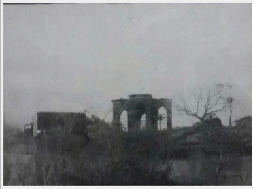
Figura 04 – Construção da Igreja do Horto
