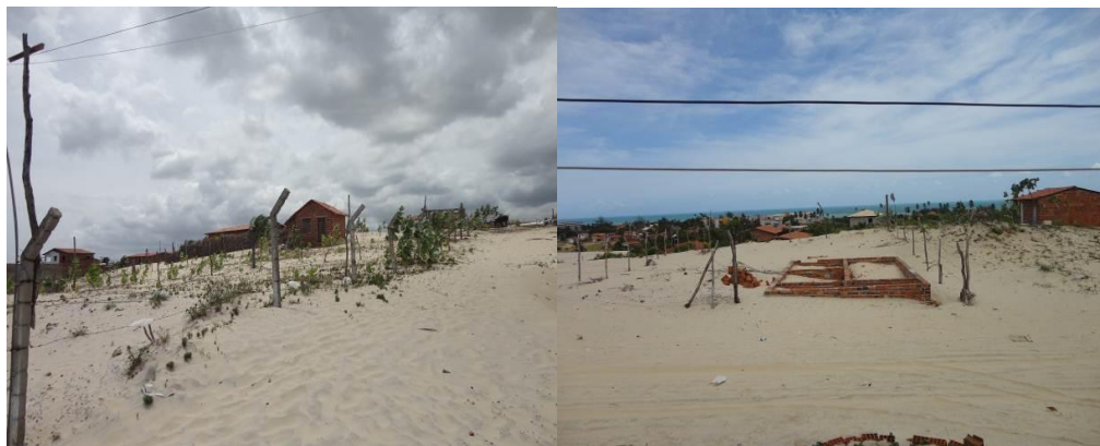
Figura 4 – Crescimento da ocupação irregular no bairro Parazinho com construções de alvenaria
