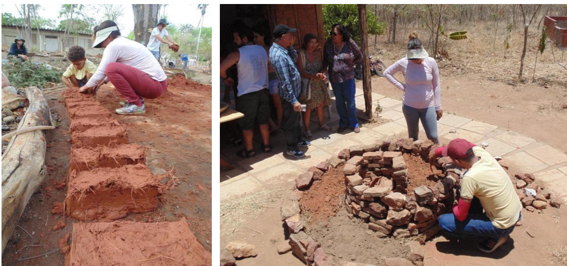
Figura 4 - Vivência de bioconstrução e ecologia cultivada e: a) fabricação de tijolo de adobe; b) implantação de jardim comestível.
