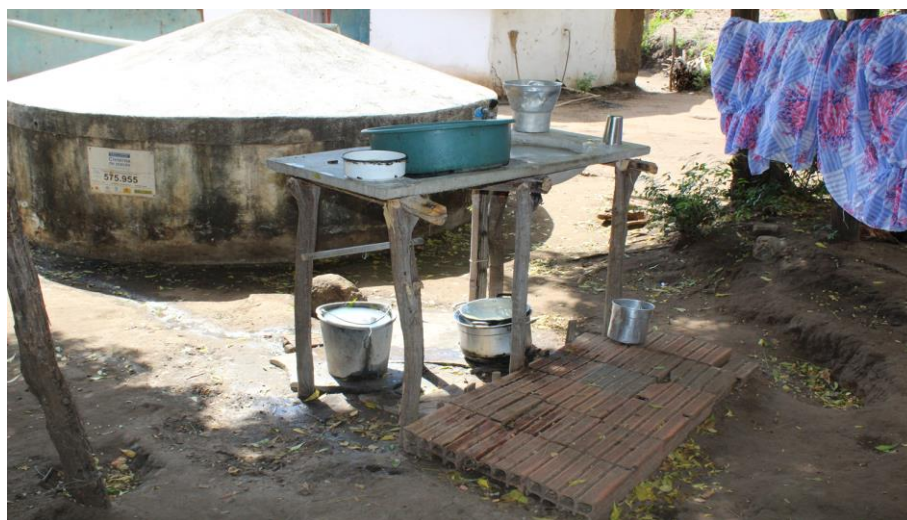
Figura 5 - Cisterna de 16 mil litros
