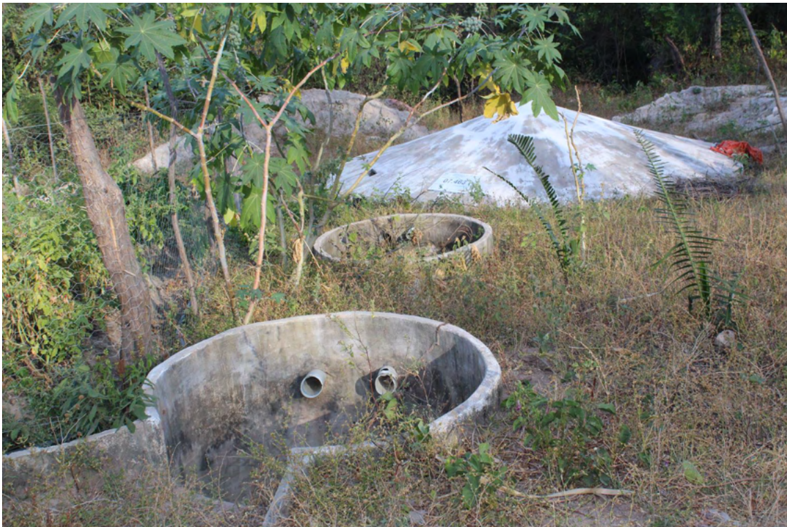
Figura 6 – Cisterna de Enxurrada
