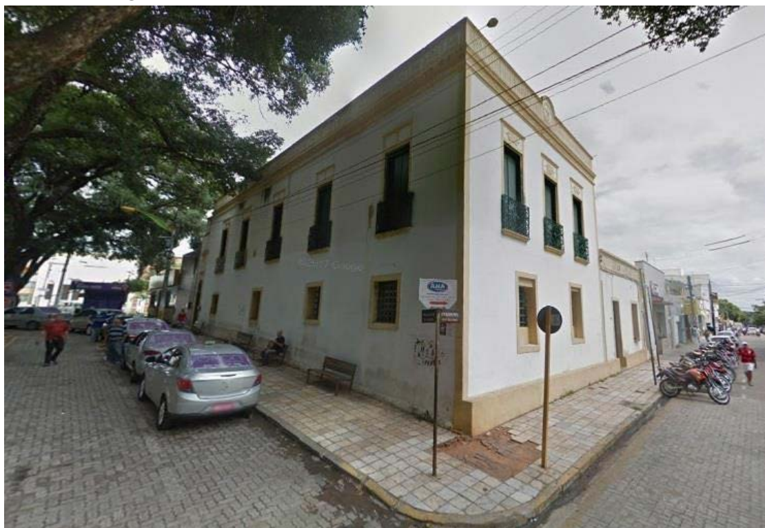
Figura 3 - Fachada da Casa de Câmara e Cadeia do Crato
