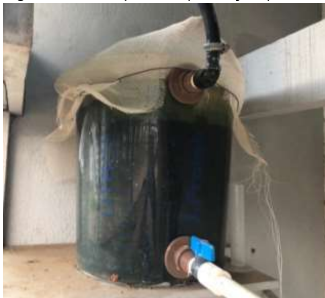
Figura 12 – Tanque de equalização (afluente)
