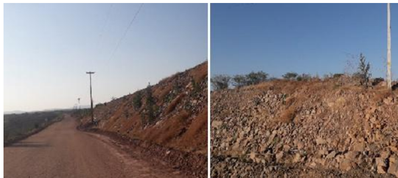
Figura 10 – Materiais extraídos nas escavações e seu emprego na obra
