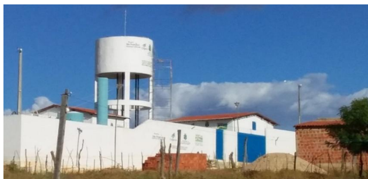
Foto 12 – Caixa d'água para abastecimento de comunidades rurais
