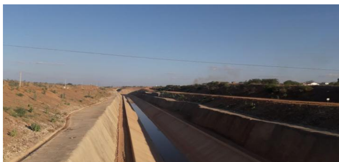
Figura 13 – Canal do PISF funcionando em Penaforte
