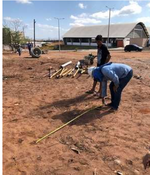
Figura 32- Demarcação das estacas
