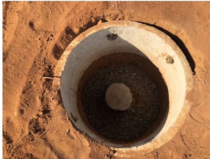
Figura 37 - Tapete drenante de brita e sensor instalado
