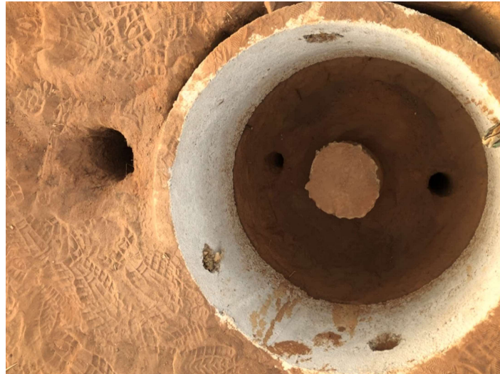
Figura 36 - Furos dos drenos e do sensor
