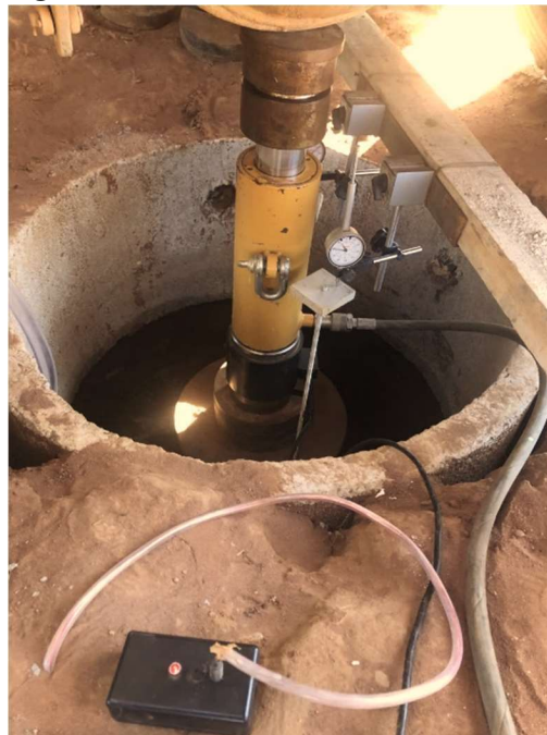
Figura 40 - Inundação do solo no entorno da estaca
