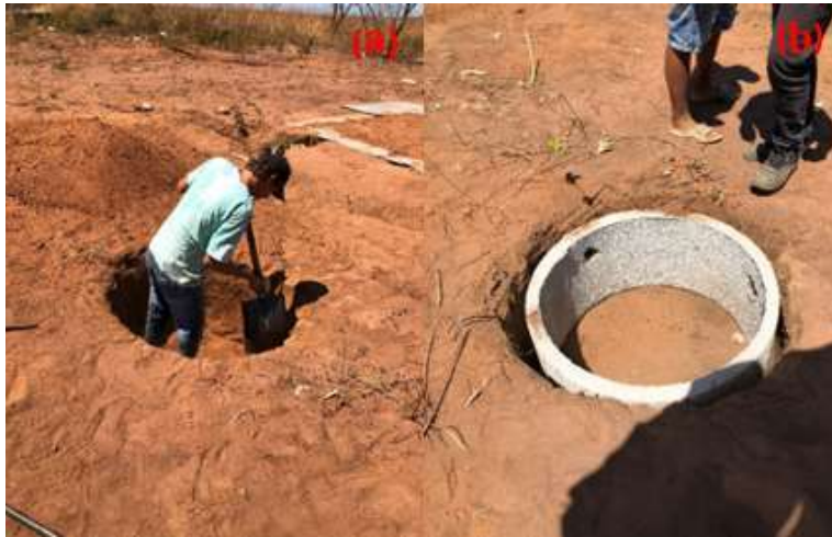
Figura 33 - Escavação da cava (a); manilha posicionada na cava (b)
