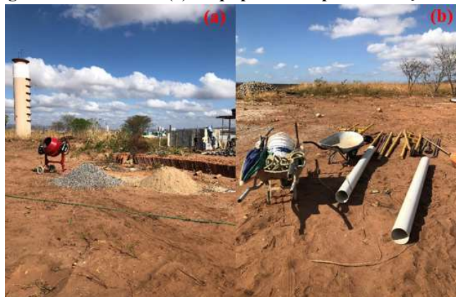
Figura 27 - Materiais (a) e equipamentos para execução das estacas
