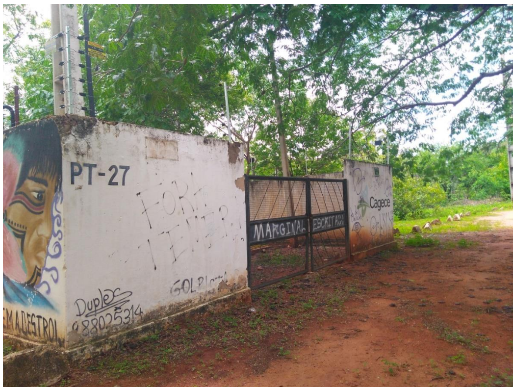
Figura 16 – Poço da CAGECE que opera normalmente.
