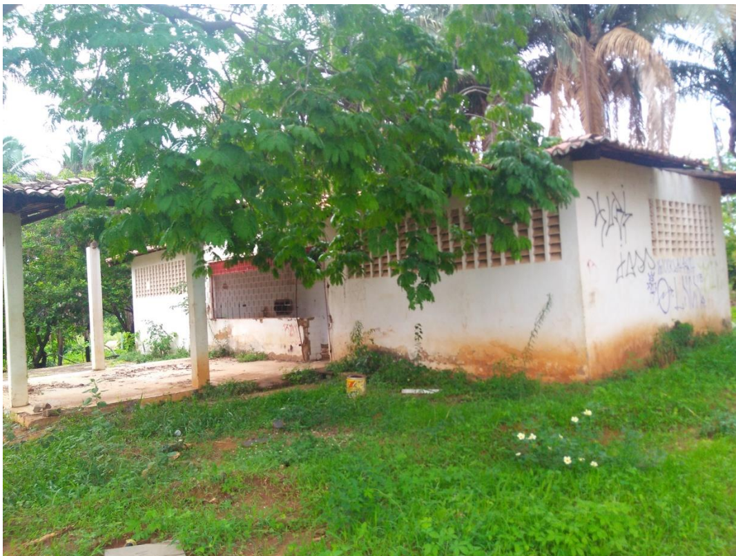
Figura 20 - Construção atualmente abandonada.
