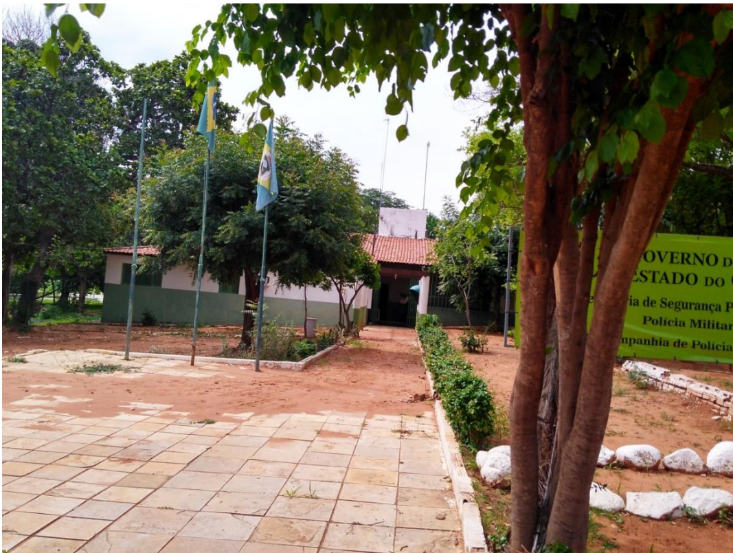
Figura 10 – Prédio onde funciona a polícia ambiental
