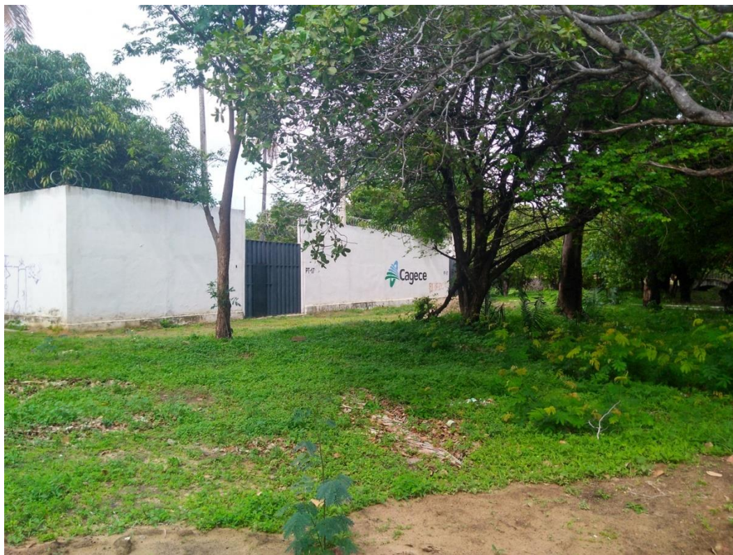
Figura 15 - Poço da CAGECE para abastecer as bicas e o Parque, desativado.
