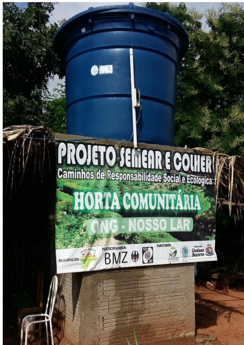
Figura 08: Poço profundo e caixa d'água na horta comunitária.
