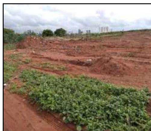
(c) Área em processo de terraplanagem – Jardim Gonzaga
