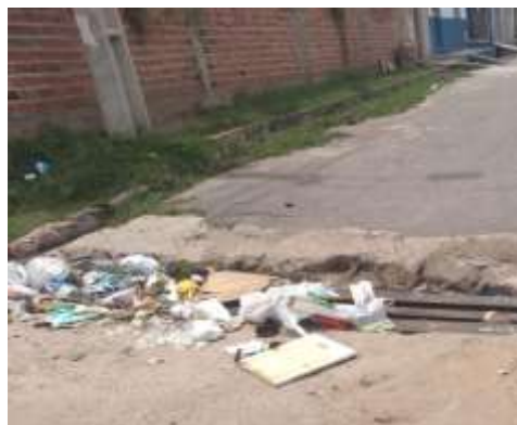
(b) Galeria de drenagem na av. Jose Bezerra cheio de resíduos sólidos
