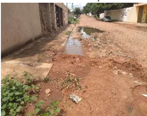
(g) Pt18-Meio fio obstruído com sedimento formando poça d'água na rua e causando buracos na pavimentação
