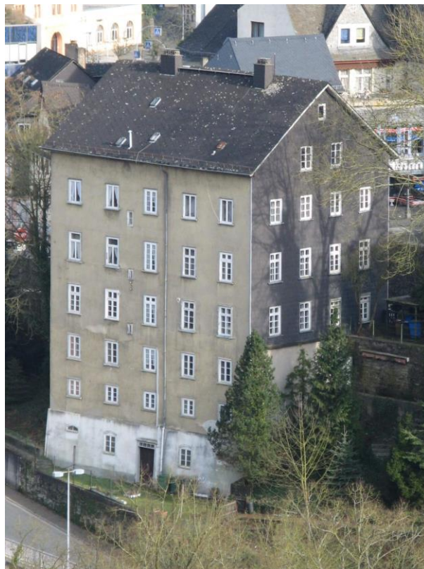
Figura 6 – Edifício de taipa de pilão localizado na cidade de Weilburg, Alemanha
