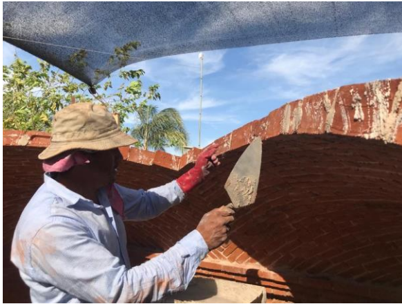
Figura 10 – Mestre bovedeiro Andrés Flores iniciando a marcação dos tijolos da abóboda
