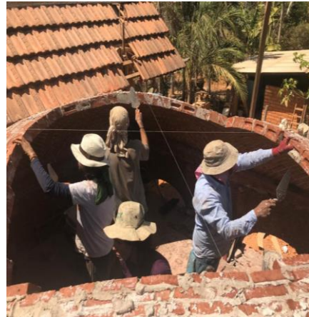
Figura 11 – Assentamento dos tijolos da abóboda
