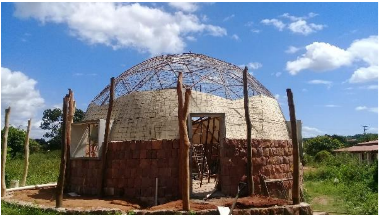
Figura 30 – fotografia da construção da residência em andamento
