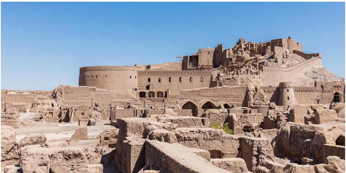
Figura 5 – Arg-e Bam, edifício construído com tijolos de terra crua entre os séculos VI a.C. e IV a.C, na região do Irã
