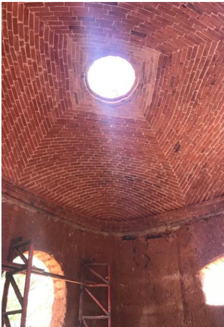
Figura 12 – Coberta com abóboda finalizada
