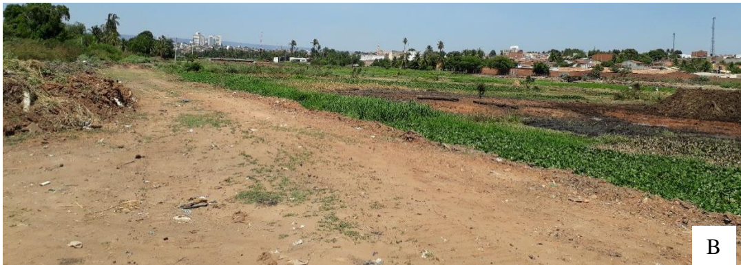
B – Estrada aterrada barrando a desembocadura do riacho das Timbaúbas no riacho dos Macacos e ao fundo da imagem a presença de edificações.
