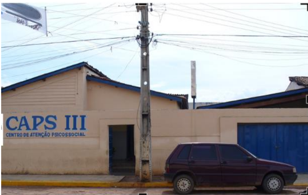
Fotografia 1 - CAPS III Barbalha - CE
