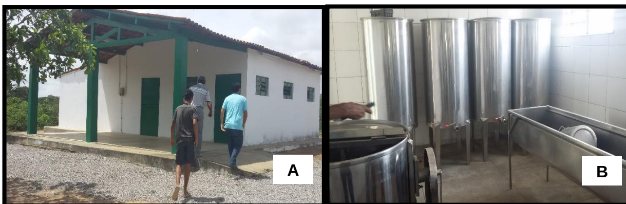
Figura 8. A - Casa do mel, B - equipamentos pertencentes a casa do mel da comunidade Serra Brejinho.
