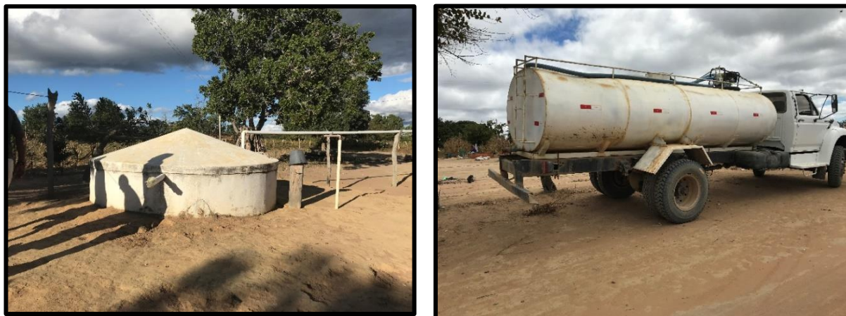
Figura 17: A - Cisterna ao lado da casa, B - Carro pipa para abastecimento na falta de água.
